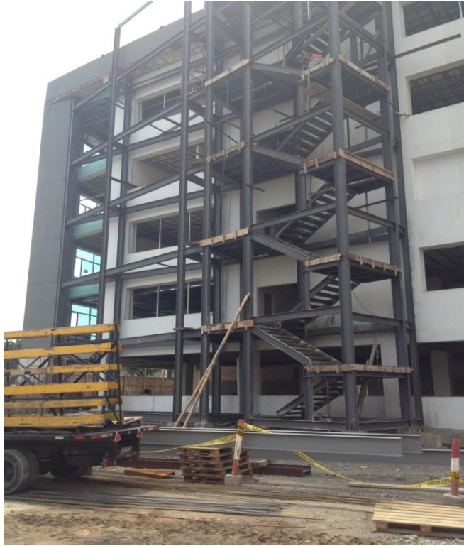
Fig # 3 EDIFICIO EN CONSTRUCCIÓN
