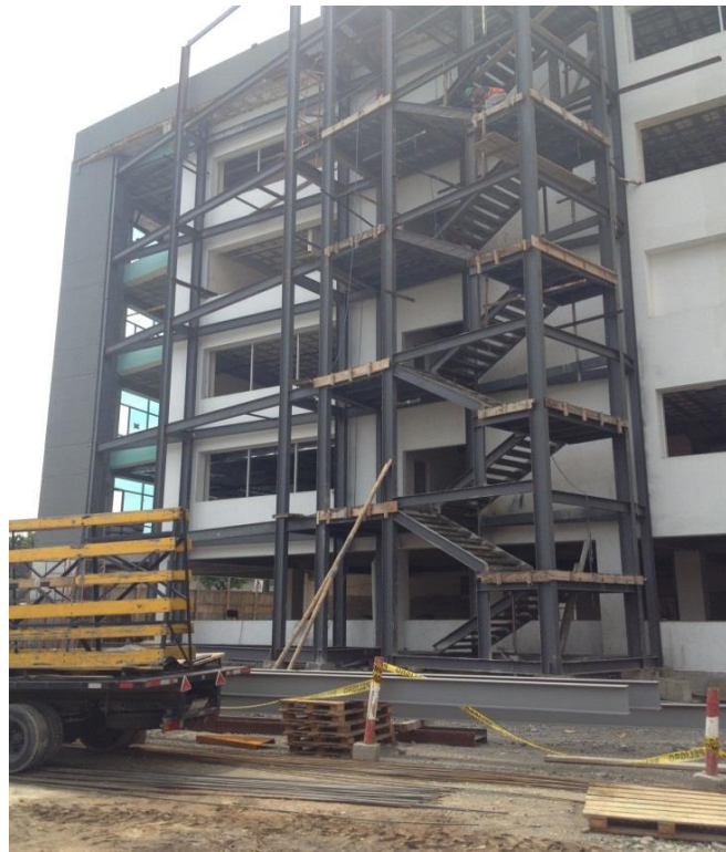
Fig # 3 EDIFICIO EN CONSTRUCCIÓN
