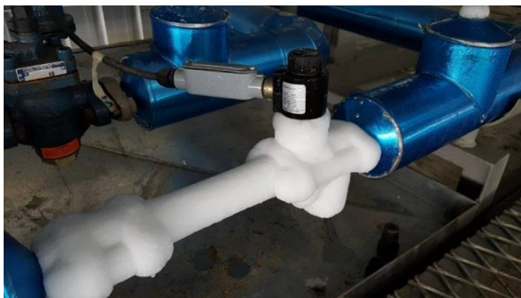
Figura 2.18 Válvula solenoide
