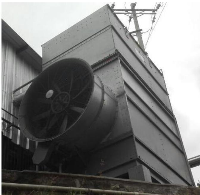
**Figura 2.4: Condensador Evaporativo**
