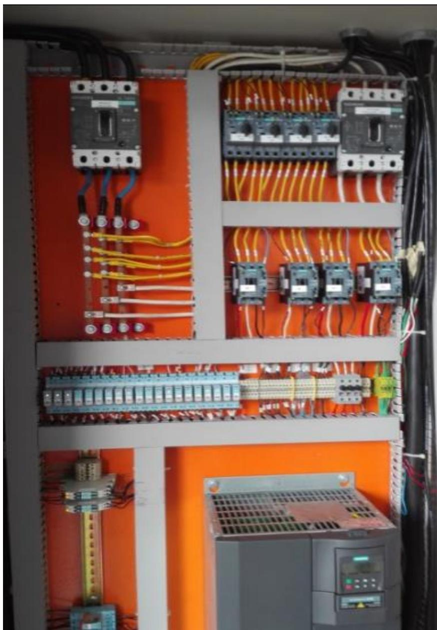
**Figura 4.8: Tablero de Fuerza de control de bombas y ventilador**
