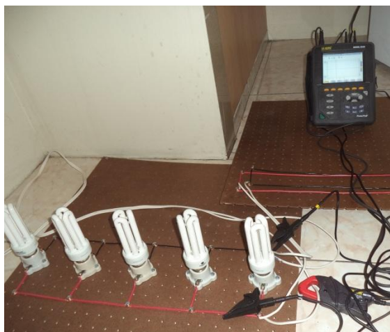
Figura 1.9: Montaje del Banco de Pruebas para TEST 1-G5 con Power Pad AEMC 8335
