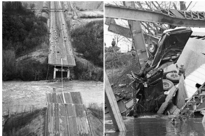
Figura 1.2: Caída del Puente Silver Bridge
