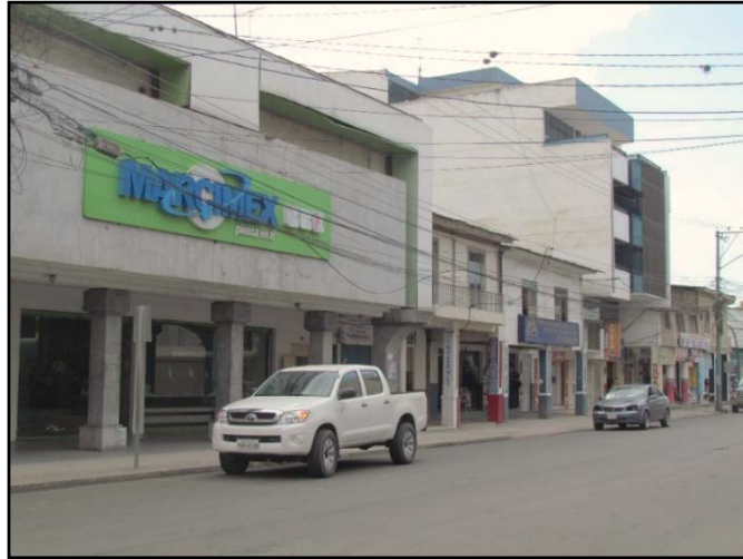
Figura 1.5: Cable holgado entre vanos, Av. Rocafuerte entre Tarqui y Colón.
