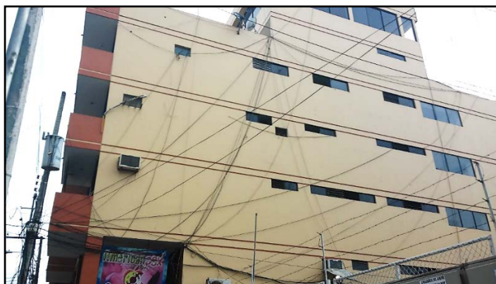
Figura 1.8: Edificio envuelto en cables. Avenida Rocafuerte y Tarqui.
