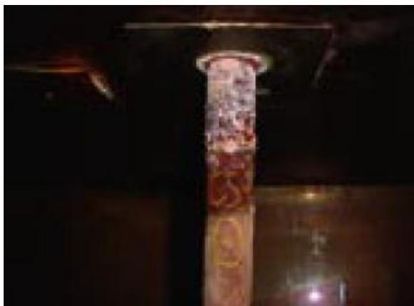
**FIGURA 2.13 CORROSIÓN POR FILTRACIÓN DE AGUA EN LA CARCASA DEL HRSG [12].**
