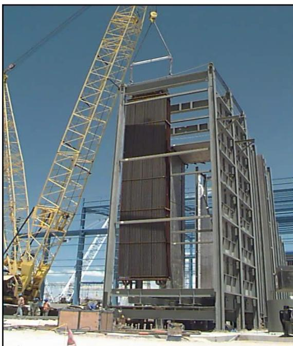
**FIGURA 2.11 INSTALACIÓN DE UNA SECCIÓN TIPO ARPA [11].**
