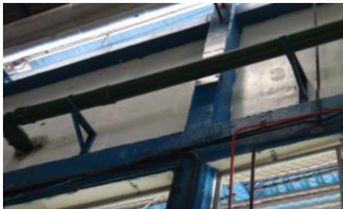
Figura 4 Fijación de Soportes a la Estructura de la Planta.
