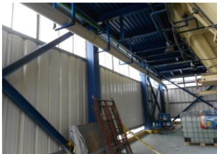
Figura 4.3 Construcción de Soportes para Tubería Principal,
