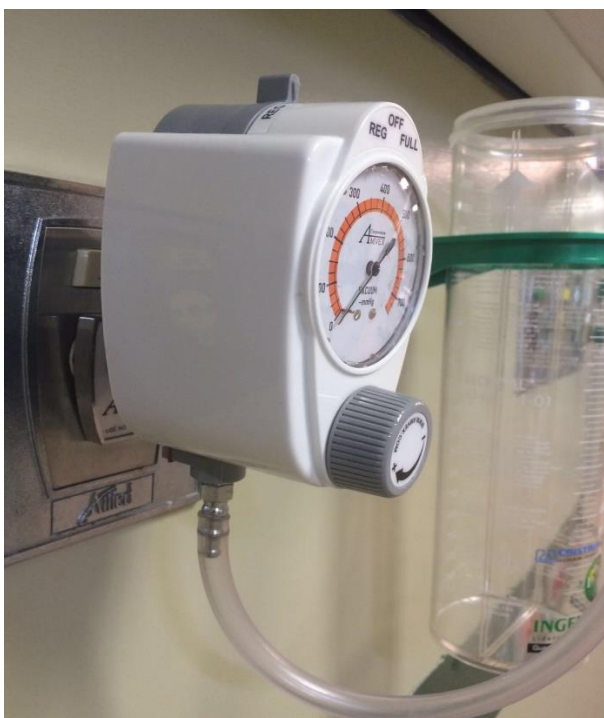
Figura A4.6: Conector de toma de Vacío
