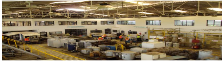
Figura 1 .1: Vista panorámica de la planta de transformadores
