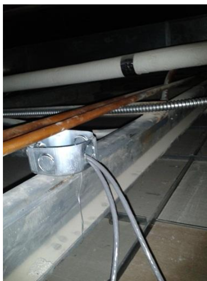
Figura 2.5: Instalación de cableado
