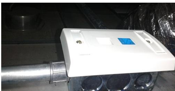
Figura 2.6: Instalación de Jacks
