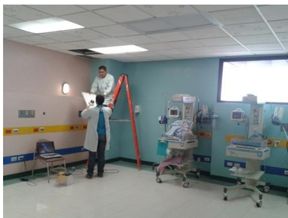
Figura 2.3: Instalación de cámara en área de UCI
