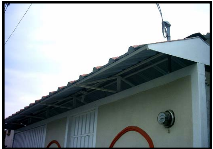
Estructura Metálica para techo
