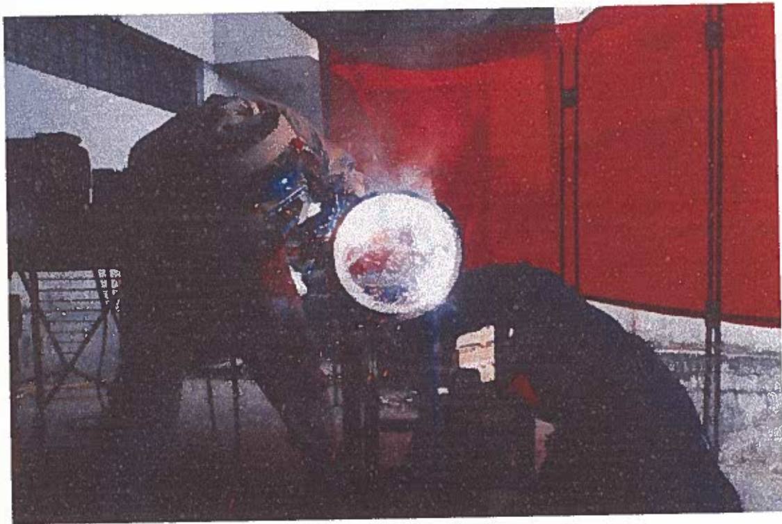
Fig. 12 Realizando soldadura en tubería con proceso SMAW.
