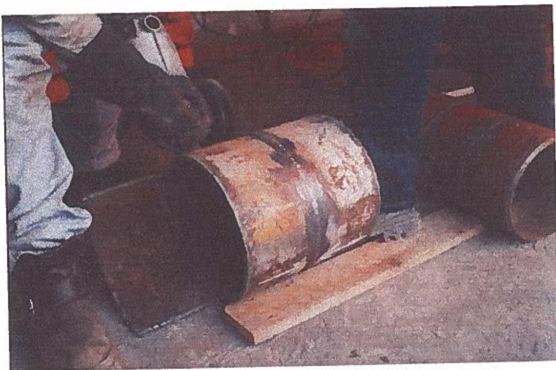
Fig. 37 Realizando la limpieza del cordón terminado para ejecutar la inspección visual.
