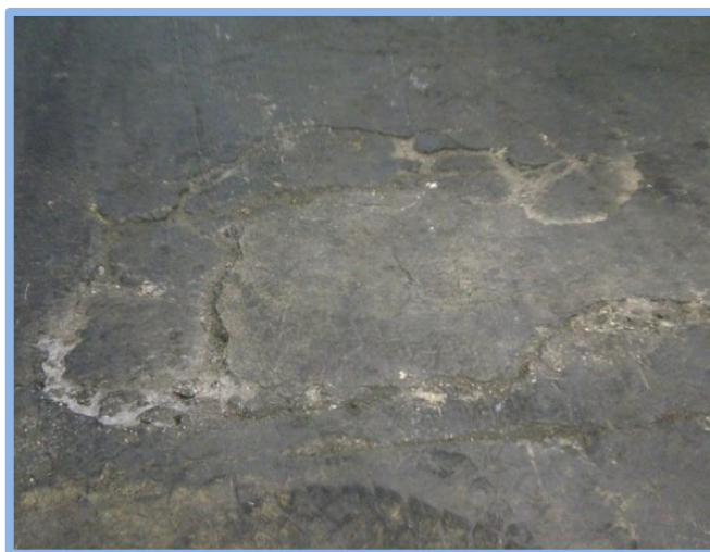
Foto 1 PISO DE BODEGA 1 MATERIA PRIMA
