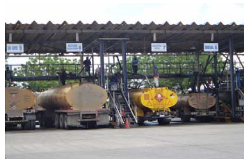
ÁREA PRINCIPAL DE LA PLANTA (ISLA DE CARGA)
