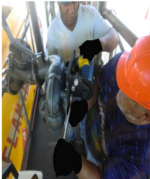
11.- Ajustar las piezas que sostienen el nuevo balancin del brazo de carga.
