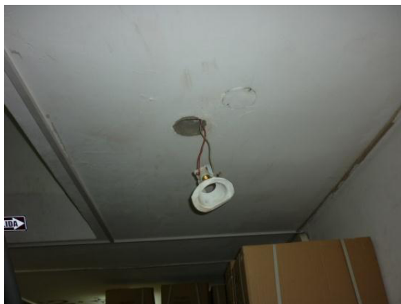
Figura 4.1.4 de la iluminación en las bodegas
