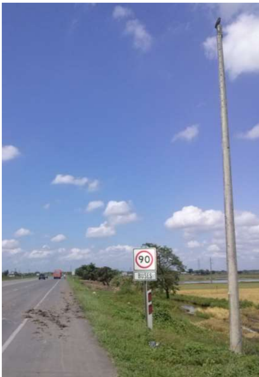
Figura 2.1: Poste sin ninguna estructura en la vía.
