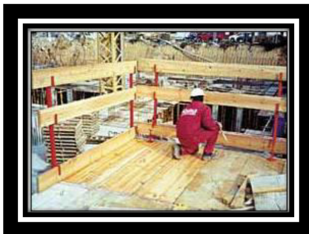
Figura 4.15 Barandillas de Protección
