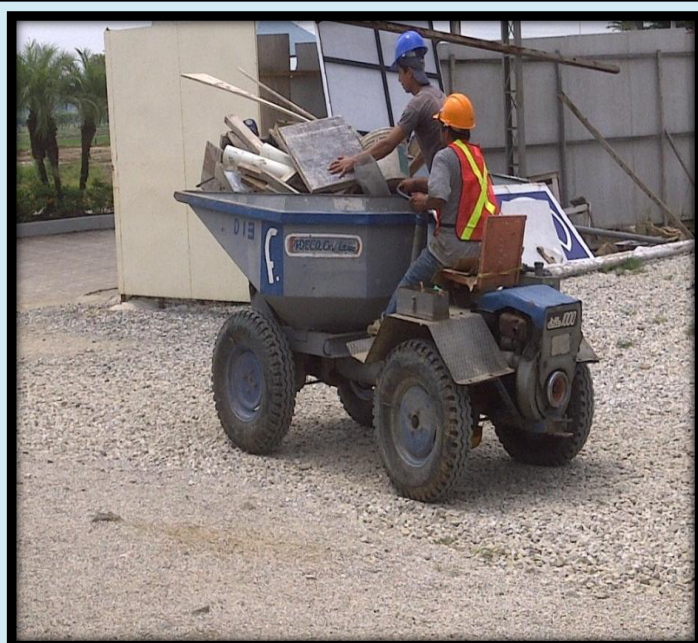
Figura 2.31 Utilización de Equipos Mecánicos
