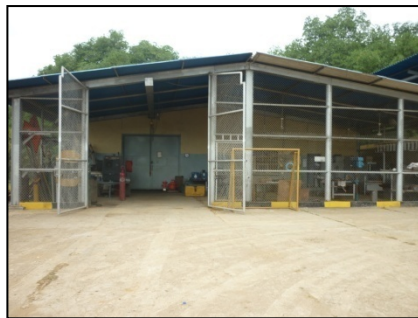
Figura 2.2 Taller de Soldadura
