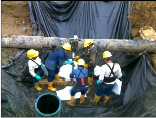
Figura 3.4 Cambio de Poliducto
