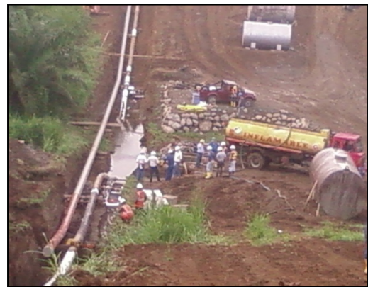
Figura 3.7 Válvulas de Control
