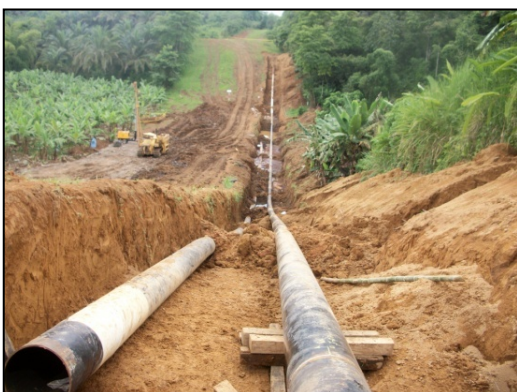
Figura 3.8 Tendido de Tubería
