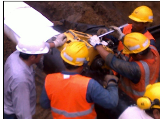
Figura 3.5 Corte de Poliducto
