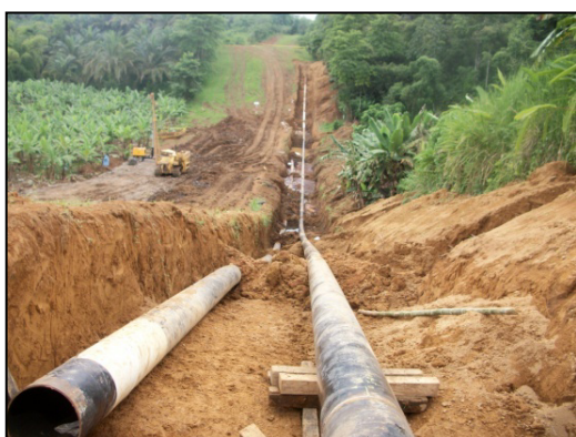
Figura 3.8 Tendido de Tubería
