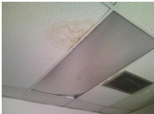
Figura 2.7 Imagen de Techo en malas condiciones
