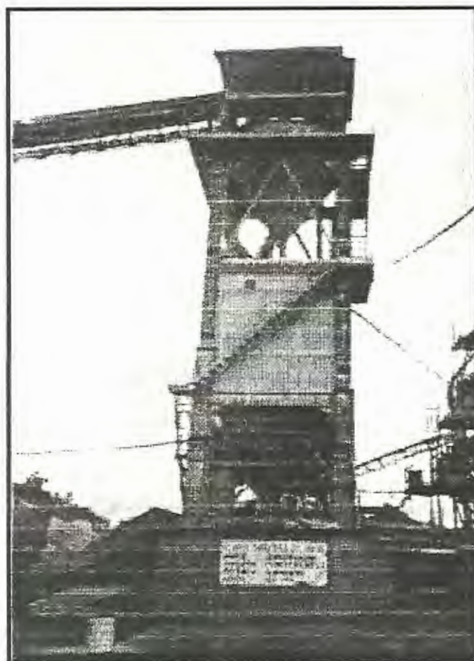
FIG 2.3. PLANTA LAVADORA DE ARENA (S-S-D)
