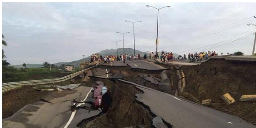
Figura 1.4: Carretera destruida vía Pedernales. [5]
