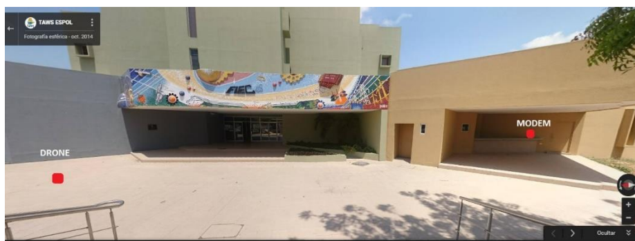
Figura 2.44: Vista panorámica de la ubicación del modem y el drone.
