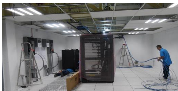
Figura 2.60: Acabados del cuarto de control
