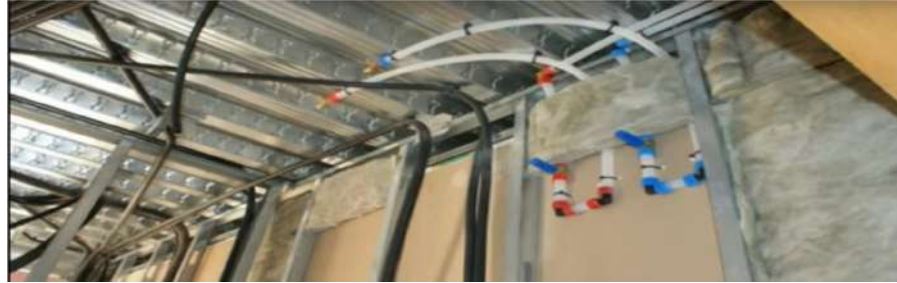
Figura 2.11 Ejemplo del armado del techo falso vista interna [15].
