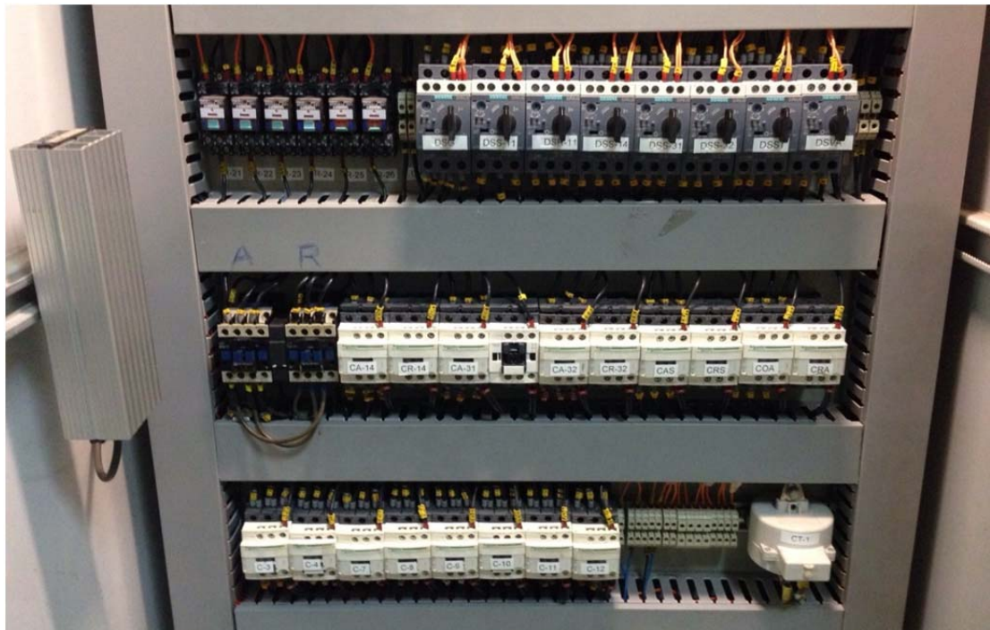
Figura 1.3: Contactores con inversión de giro y enclavamiento mecánico, contactores con arranque directo
