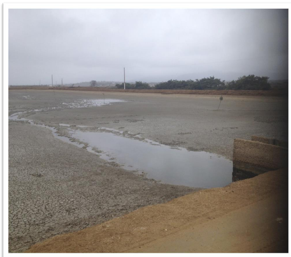
Figura No. 15 Preparación de la piscina.
