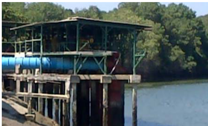
Figura 22 Estación de bombeo camaronera Ecuacultivos s.a.
