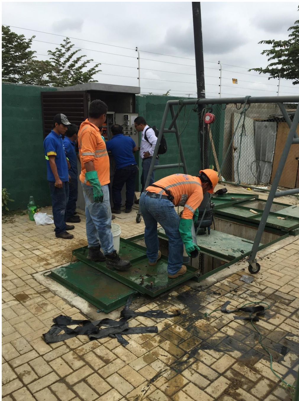
Figura 3.1: Levantamiento de bomba sumergible.
