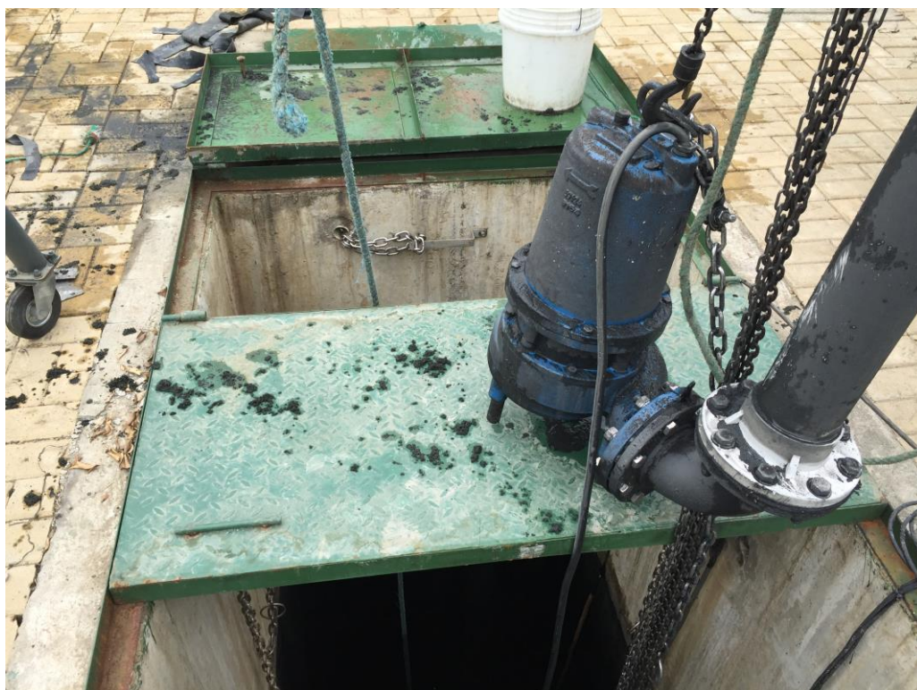
Figura 3.2: Bomba sumergible levantada para pruebas.
