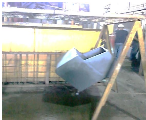
Figura 1.4: Estructura de transformador luego de ser atada
