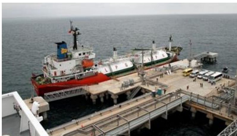
Figura 1.1 Muelle para recibimiento de buques en estación “Monteverde”, Ecuador.
