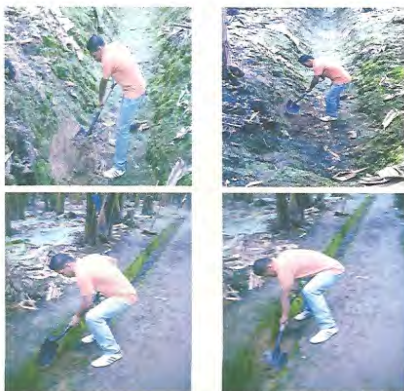
Figura 1: Limpieza de canales de drenaje
