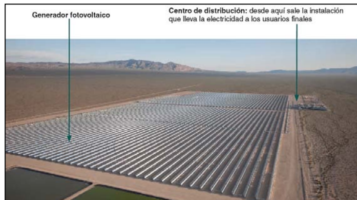
Figura 2.17 Central fotovoltaica en el desierto de Nevada. 39
