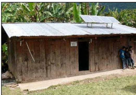
Figura 2.19 Sistema fotovoltaico con aplicación doméstica. 41
