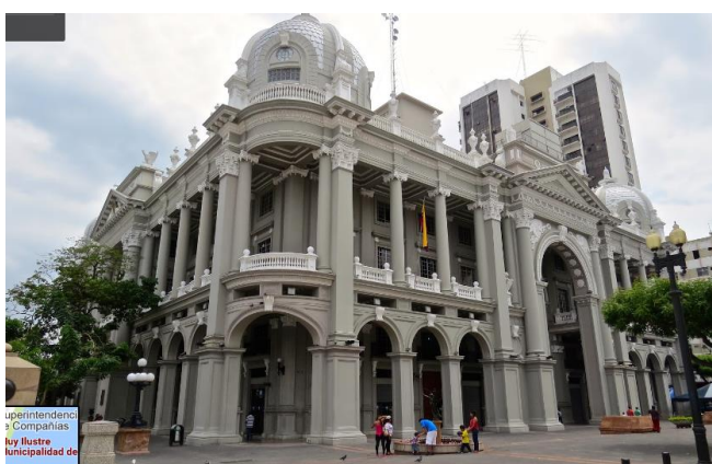
Figura 2.48: Edificio Municipal de Guayaquil [9].
