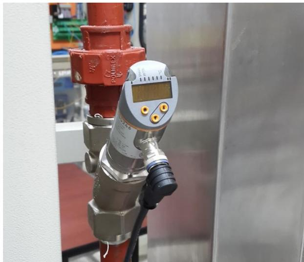
**Figura 2.2 sensor de caudal utilizado**
