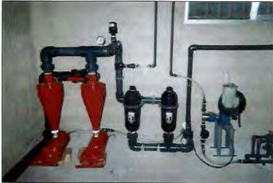
Figura 4. Cabezal de filtrado. Fuente: www.raulpalomo.com
