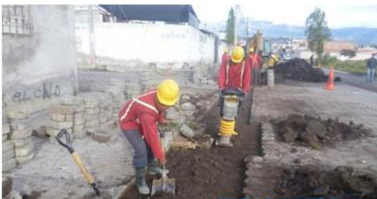
**Figura 3.2: Infraestructura, Fibra óptica subterránea**
