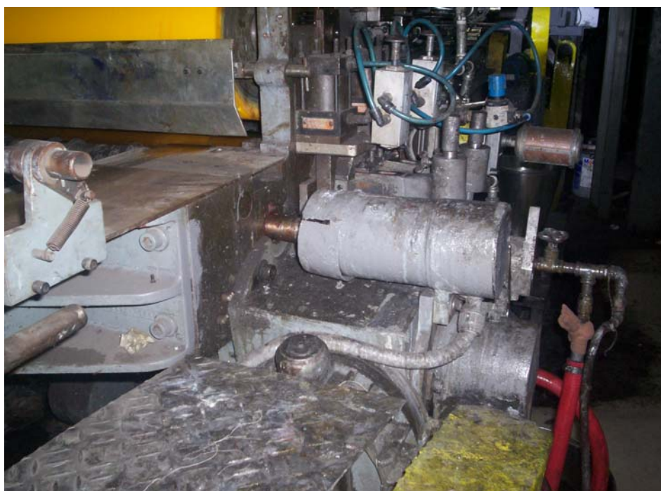
Foto 2.10 Synchro de la barnizadora
