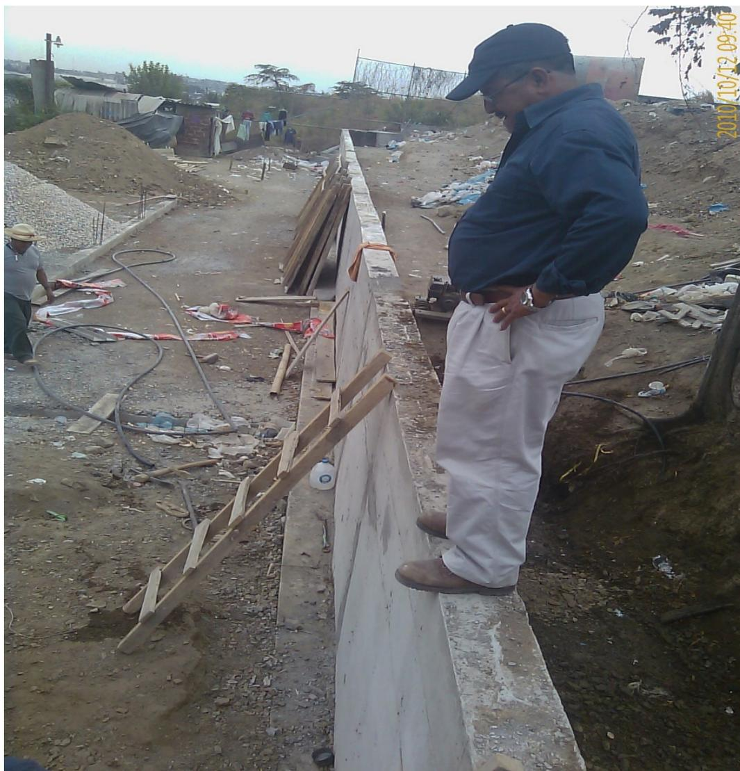
**Fig. 2.1: Muro de refuerzo, en etapa de construcción**
