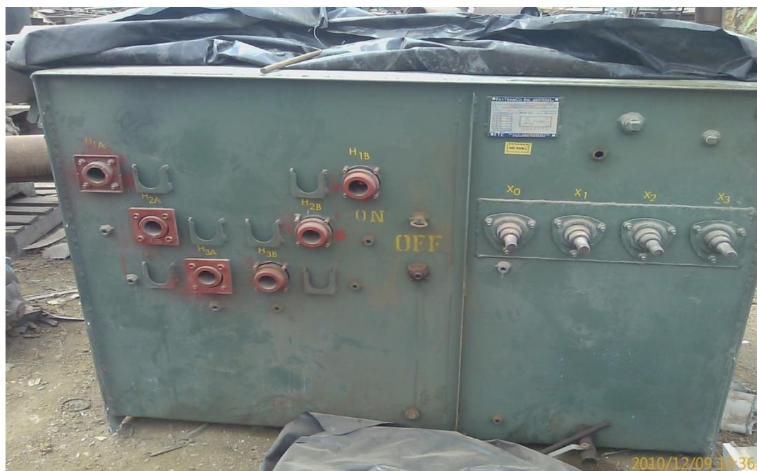
Fig. 2.6: Transformador 750 KVA usado, antes de mantenimiento
