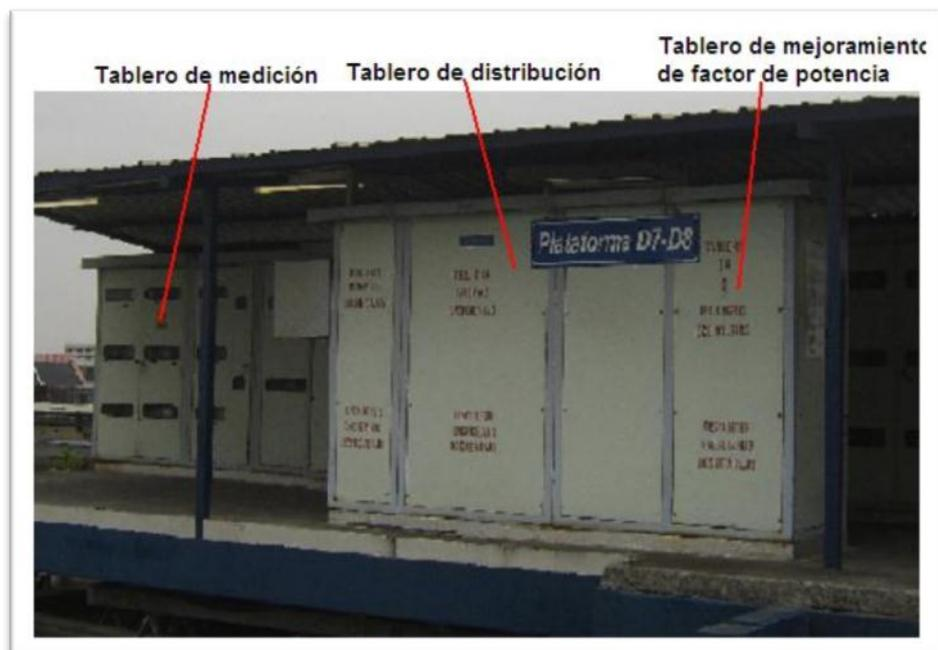
**Figura 1.6: Plataforma-Distribución y Medición.**
