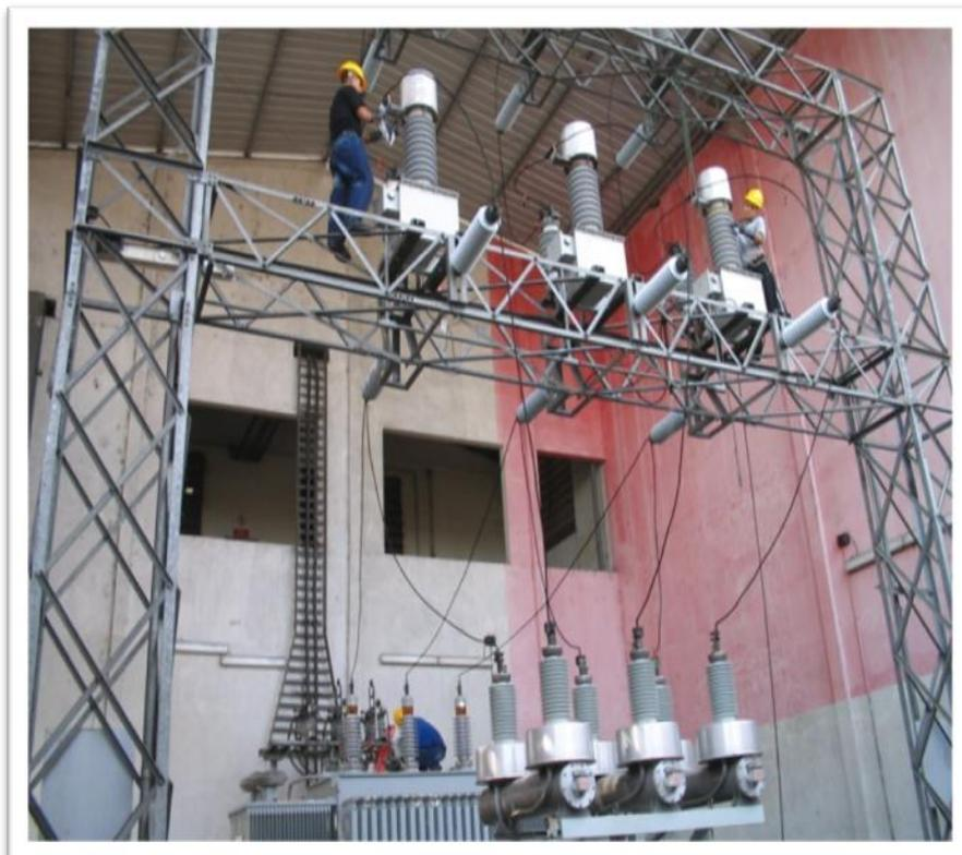
**Figura 1.2: Subestación Principal 69/13.2 KV.**
