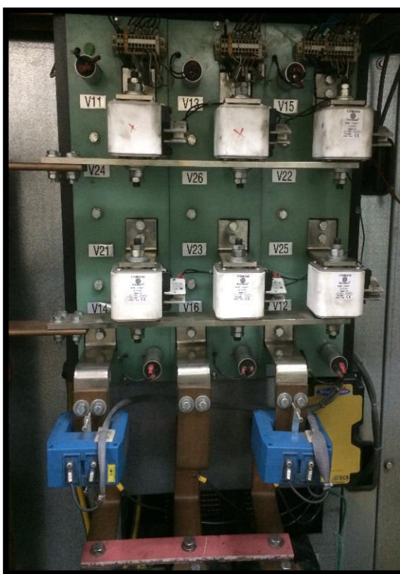
Figura 1.1 Convertidor trifásico tipo puente
