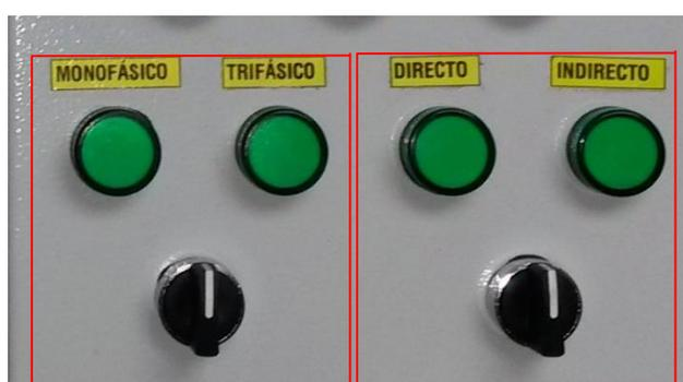
Figura 4.5 Selectores para modo de alimentación y conexión.
