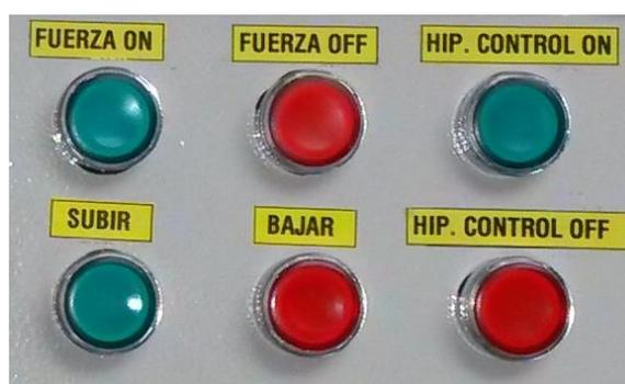
Figura 5.16. Control Manual Autotransformador Hipotronic.
