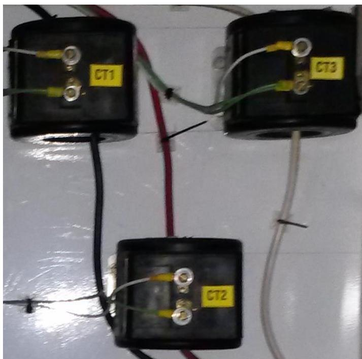
Figura 2.11. Transformadores de corriente.
