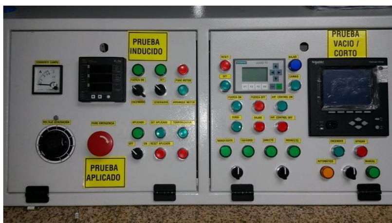
Figura 6.2. Tablero panel operador terminado.
