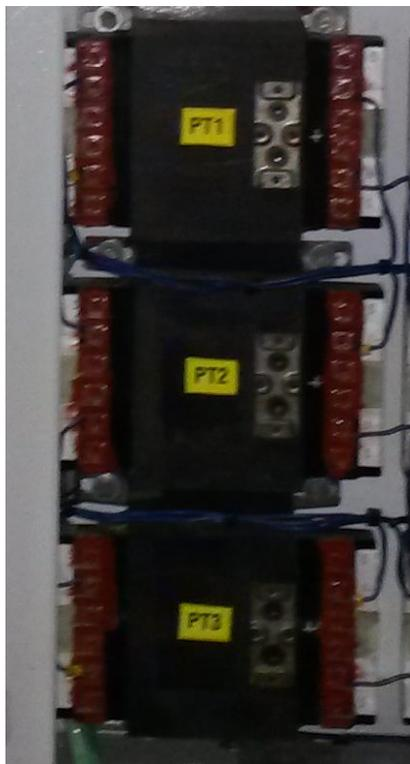
Figura 2.10. Transformadores de potencial.
