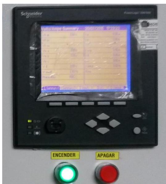
Figura 4.3. Pantalla de medición ION 7650.
