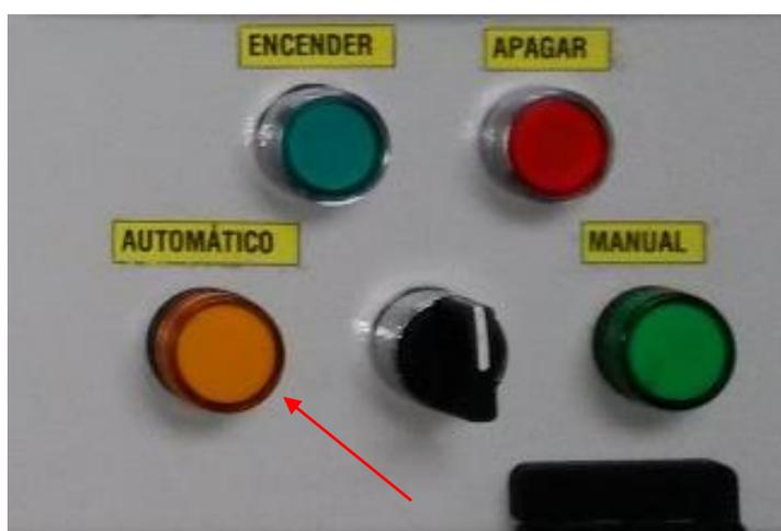
Figura 4.7. Posición del selector en modo automático.
