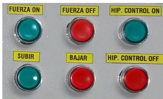
Figura 5.32. Control Manual Autotransformador Hipotronic.
