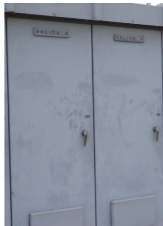
Figura 1.12 Armario de Salida de Alimentadoras
