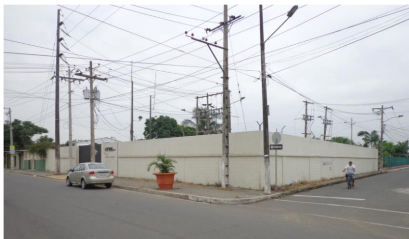
Figura 1.2 Vista externa de la S/E Durán Norte
