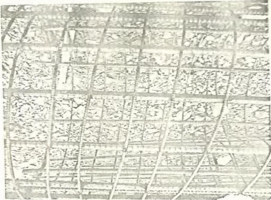
FIGURA N° 10-a.- Estructura para concreto reforzado con amarre de los estribos con alambre.
