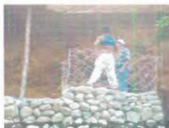
Foto 31. Muro de Gaviones
