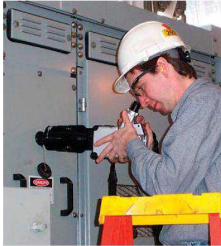
Figura 5.1: Manipulación en armarios sin guantes de protección
