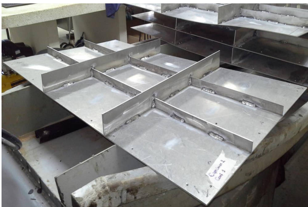
FIGURA 16. Construcción de un panel reforzado.
