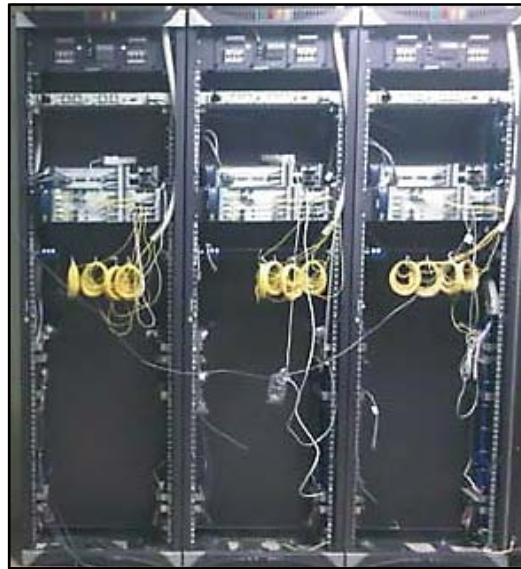
Figura 3.2 Nodos OptiX OSN 1500 del laboratorio FIEC
