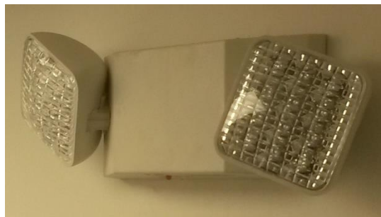
Figura 2.8: Lámpara de emergencia
